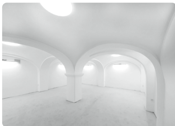
Dokončovací práce probíhají na výstavní galerii ve Slovanském domě, po opravách omítek a malbách prostorů je již nainstalováno osvětlení a nyní se čeká na dodání dlažby.
