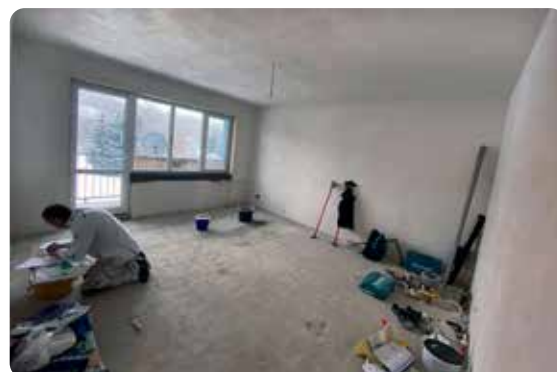
Foto: Ing. Miluše Trojanová Kompletní přestavby pokračují také v bytech panelového sídliště
