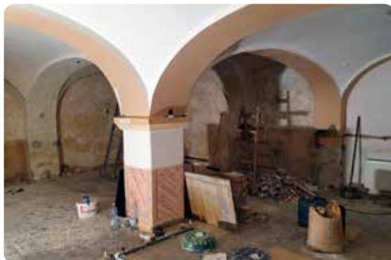
Foto: Tomáš Fúsek V přízemí Slovanského domu započaly rekonstrukce prostorů bývalé vinárny, ve které vznikne výstavní galerie
