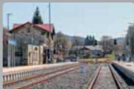
Zrekonstruovaná železniční stanice Mikulášovice dolní nádraží - str. 4
