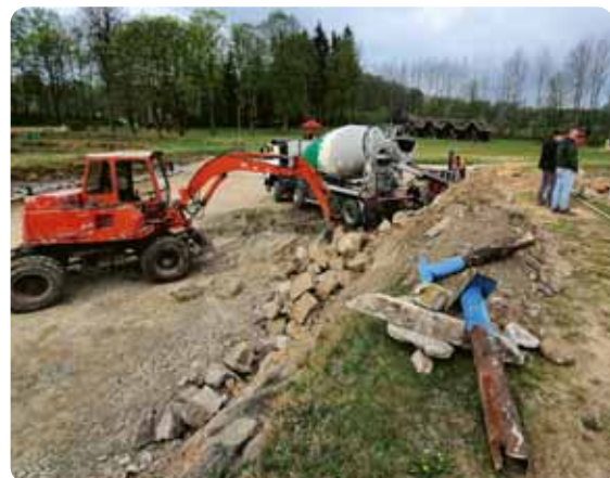
Na koupališti byla opravena hráz včetně výpustě mezi malou a velkou nádrží, která byla již v havarijním stavu.
