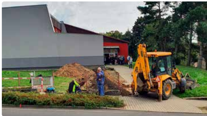
Sportovní hala se v těchto dnech rovněž připojuje na nové plynové vytápění, dobrou zprávou je, že novým systémem zlepší také průběžné ohřívání teplé vody a tím se zvýší komfort pro naše sportovce.
