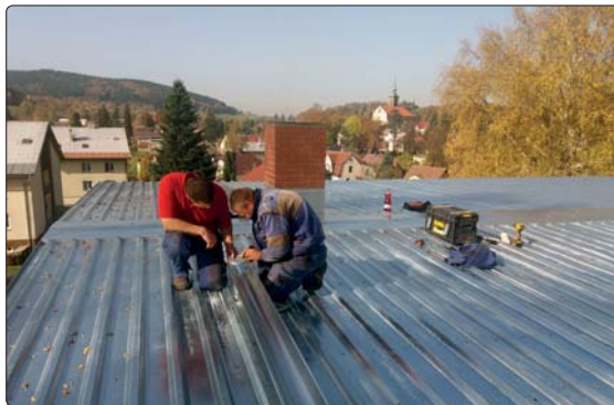
Bývalý objekt kasáren má novou střechu, po neutěšené situaci, která vznikla již před mnohými lety díky vandalům, kteří rozebrali a rozkradli oplechování střechy objektu jsme se dočkali a budovu tak zřejmě zachránili od zkázy. Realizace probíhala svépomocí a díky obětavosti pracovníků města se tak ušetřilo mnoho našich společných finančních prostředků.
