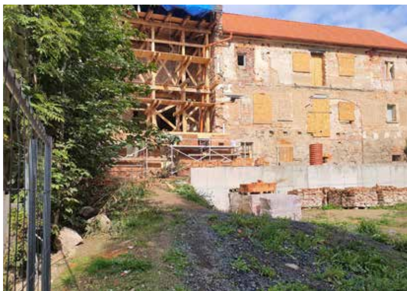
Práce se opět rozeběhly na přední i zadní straně budovy hvězdárny, důležitá je zejména obnova nosné zdi
