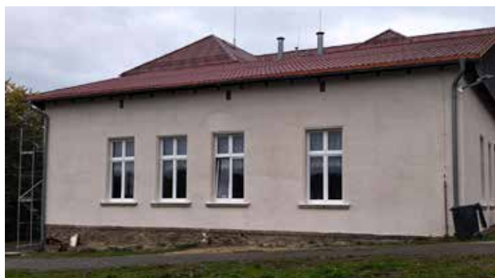
Školní jídelna s novou fasádou ještě před konečným nátěrem
