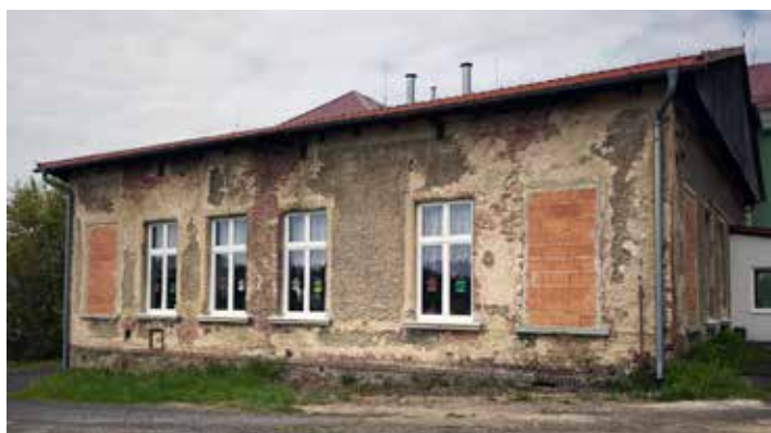
Školní jídelna před rekonstrukcí fasády
